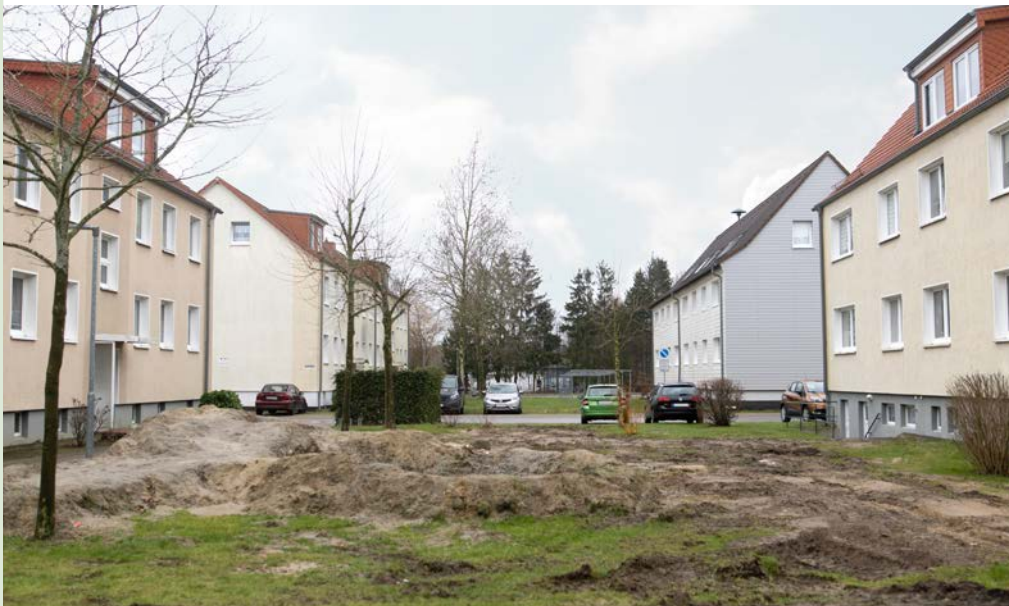
Bei den Häusern handelt es sich um typische Mehrfamilienhäuser der 50er und 60er Jahre, wie sie überall in Deutschland zu finden sind.
